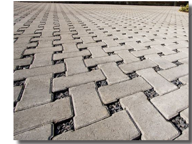
PERMEABLE PAVER EDGE
